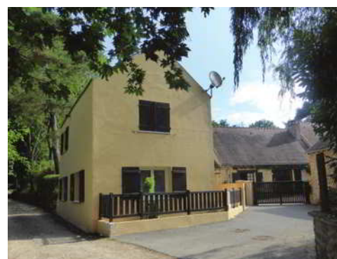
- Enduits rénovés sur maisons à Herbouvillers -
