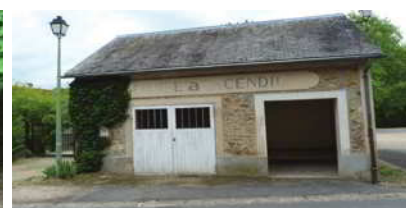
Ancien local de la pompe à incendie, en usage jusqu'à la Première Guerre Mondiale
