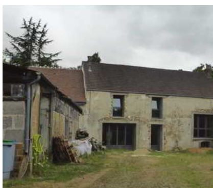
- Bâtiment en cours de réhabilitation à La Ferté Rue de la Grande aux Moines -
