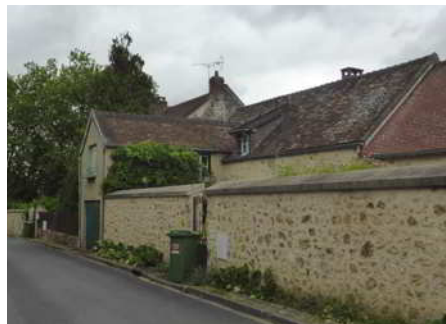
- Bâti ancien avec mur réhabilité avec un enduit à pierres vue à La Ferté -
