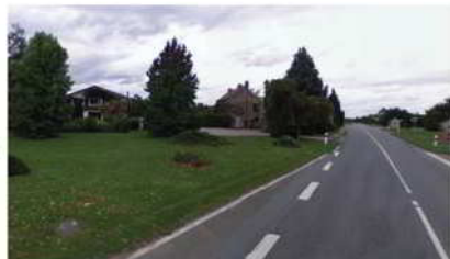
Des habitations longent la RD906, séparées de la voirie par des espaces paysagers
