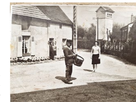
Photographie prise le 2 mai 1962 lors de la lecture d'un message à Herbouvilliers.
